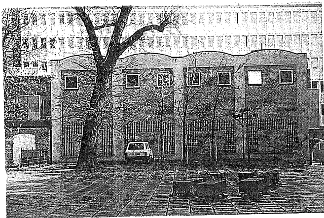
Det ny sognehus afslutter kirkepladsen mod Gutenberghus. Foran "vandrer" kasserede Rundetårns-konsoller over pladsen. Foto: Keld Helmer-Petersen.
