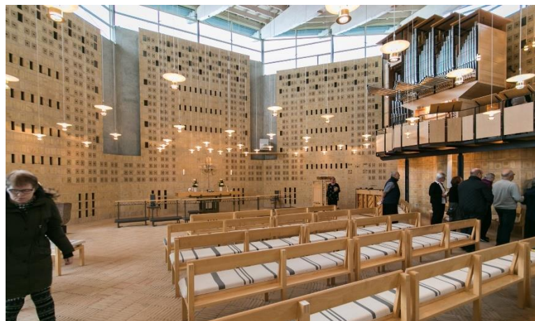
10. 8 Kirkerummet med skalmuring af tegl om betonmur
