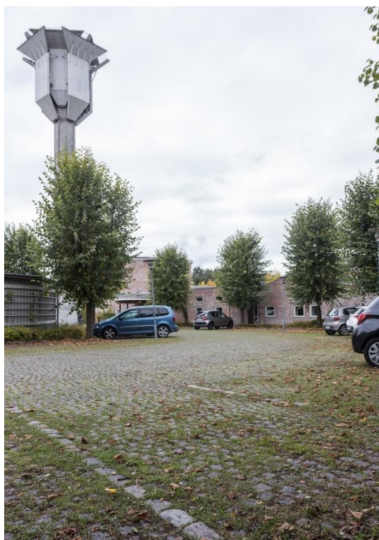
9. 2 Opstandelseskirken's parkeringsplads. Udsyn mod klocketårnet og kirkeanlægget
