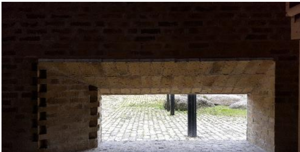
2. 9 Lavt vindue i kirkerummet
