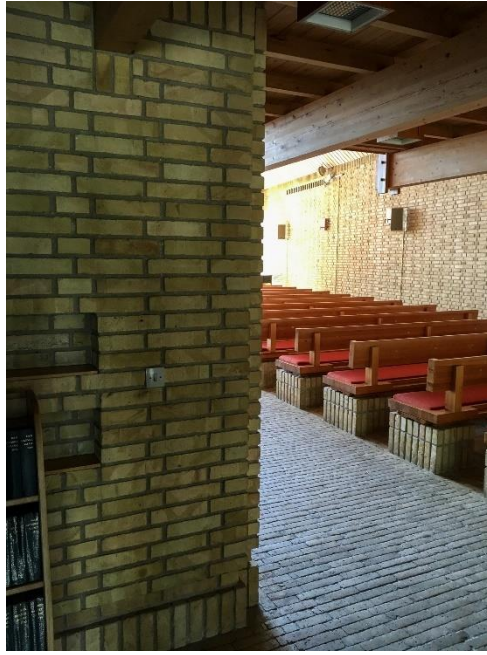
1. 3 Mursøjle ved indgangsdøren til kirkerummet
