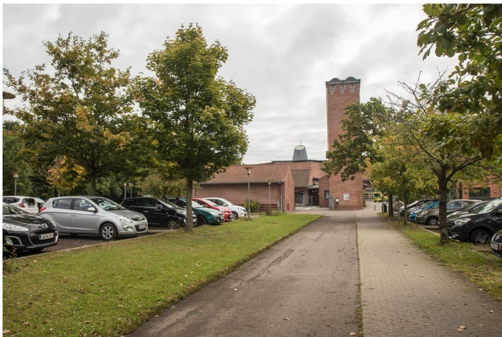
13. 2 Ølby Kirke set fra parkeringspladsen nær Stensbjergvej
