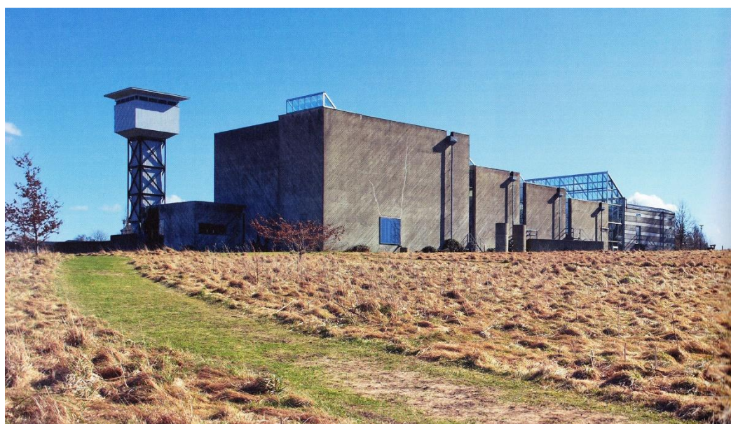
6. 2 Kirkeanlæggets aftrappede kuber. Foto Aage Lund
